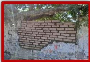
Reparación de 4 m<sup>2</sup> de en la barda correspondiente al estadio Rosendo Arnaiz frente a la avenida Lázaro Cárdenas norte, a base de tabicón juntado con una mezcla de mortero-arena.
